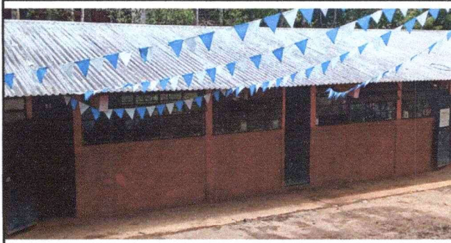
Foto1: APLICACIÓN DE PINTURA ANTICORROSIVO ROJO OCCIDO AL MODULO 2 DEL CENTRO EDUCATIVO Y APLICACIÓN DE PINTURA EN MURO INTERIOR Y EXTERIOR CELESTE Y AZUL NACIONAL.
