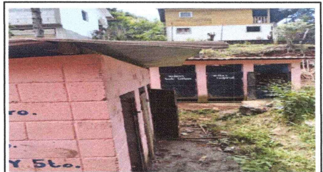
Foto 4: AMPLIACION DE BAÑOS, CAMBIO DE TAZA, PINTURA ANTICORROSIVA EN PUERTAS DE BAÑO Y SUSTITUCION DE LAMINAS Y ESTRUCTURA DE TECHO
