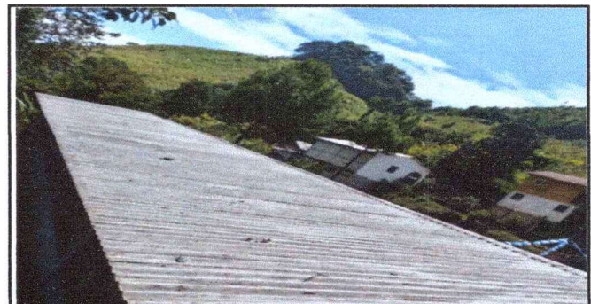
Foto 6: colocacion de canales para bajada de agua, sustitucion de laminas galvanizadas del modulo 1 por laminas troqueladas calibre 26 y pintura en muro interior y exterior del modulo 1.
