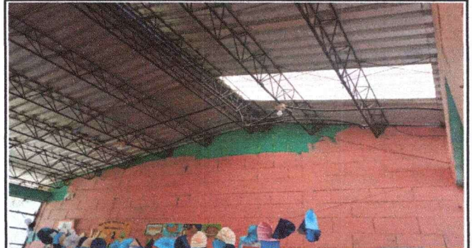
Foto 2: SUSTITUCION DE COSTANERA DE HIERRO POR COSTANERAS DE METAL
