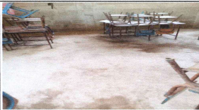
Foto 3: SUSTITUCION DE PISO DE CONCRETO POR AZULEJOS
